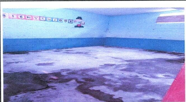
Foto 3: Curado de superficie con ácido muriático para pegado de piso en salones de 4to.B y 4to.C
