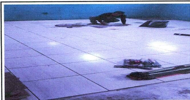
Foto 5: Colocación piso cerámico en salones de 4to.B y 4to.C
