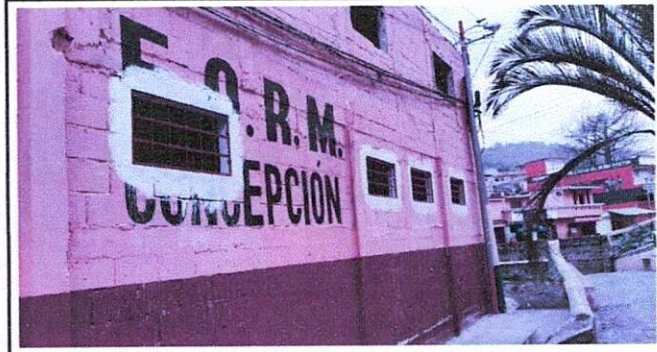
Foto 4: Colocación de rejillas en ventas externas en salones de 4to.B y 4to.C
