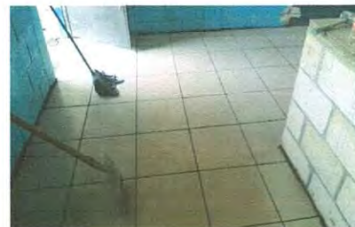
Foto 6: piso instalado para area de cocina
