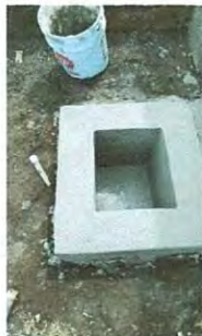
Foto1: caja de agua de estas se hicieron dos, caja de aguas negras
