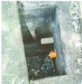
Foto1: caja de agua de estas se hicieron dos, caja de aguas negras
