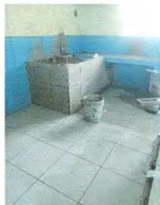
Foto 1: pila casi terminada
