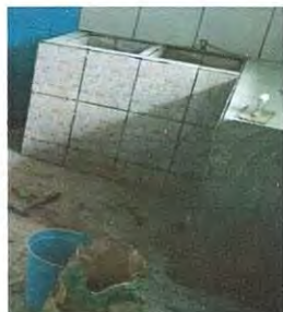
Foto 3: pila casi terminada
