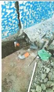
Foto 4: ingreso y salida de agua y drenaje de la pila en la cocina
