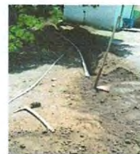
Foto 2: tubería para agua potable, inicio de tubería de agua potable hacia la cocina
