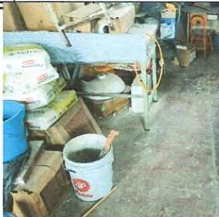
Foto1: antes de la colocación del piso nuevo
