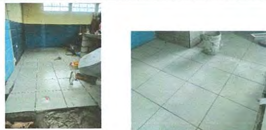
Foto 4: casi finalización de la colocación del piso en cocina
