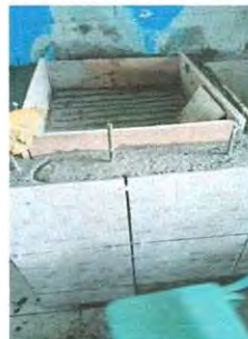
Foto 2: terminación de lavadero en la pila para cocina
