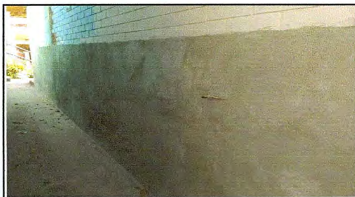
Foto: 4) 15 metros de zocalo de pared de los baños de hombres.
