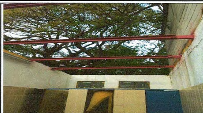
Foto: 2) 70 metros de desmontado e instalaón lámina en mal estado y mantenimiento de costaneras en lo ambientes de educación física
