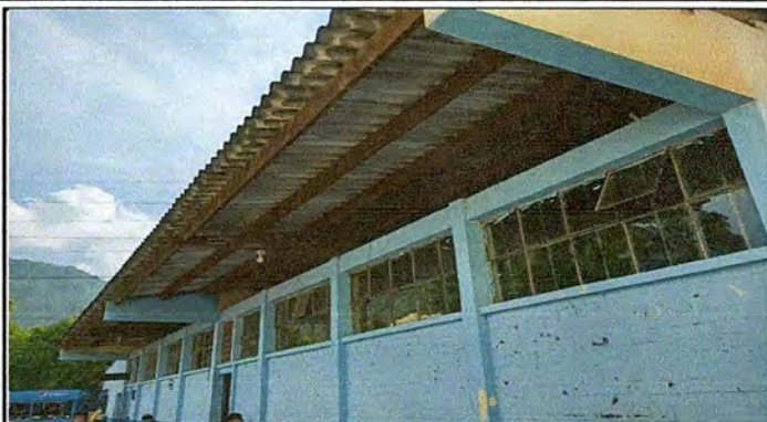
Foto: 1) Cambio de lamina duralita muy deteriorada por lámina acanalada.
