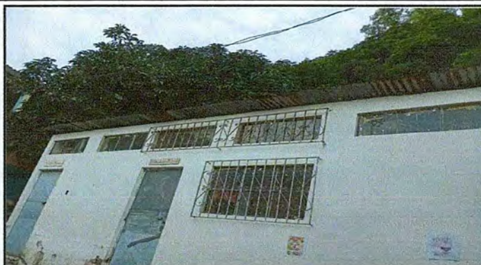
Foto: 2) 70 metros de desmontado e instalación lámina en mal estado y mantenimiento de costaneras en lo ambientes de educación física
