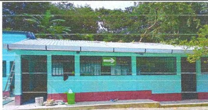
Foto 2: Instalación de canales con bajadas de agua.
