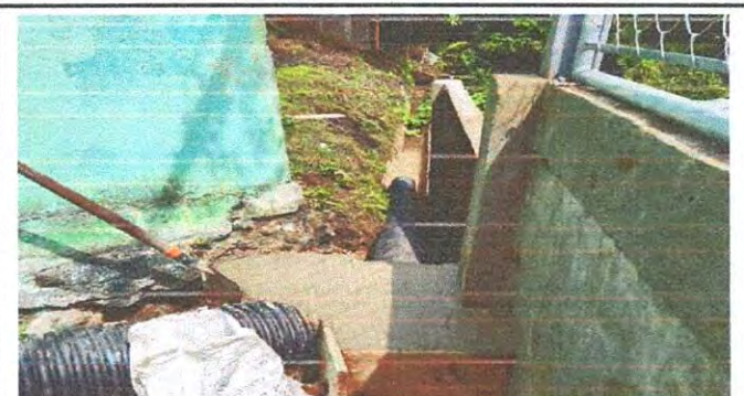
Foto 4: Ampliación de tubería para drenaje.
