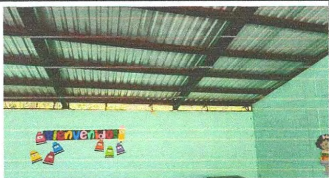
Foto 3: Instalación de mosquitero
