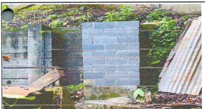
Foto 5: Levantado de muro para drenaje.
