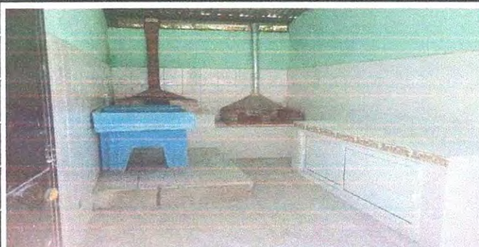
Foto 2: Azulejeado de estufa y mesa de concreto e instalacion de puertas para mesa de concreto.
