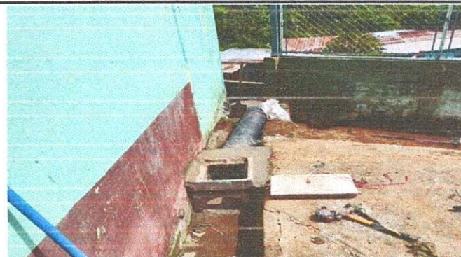
Foto 4: Instalación de caja y tubería para drenaje.
