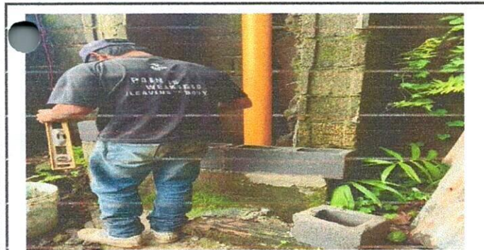
Foto 5: Fundicion del muro para drenaje
