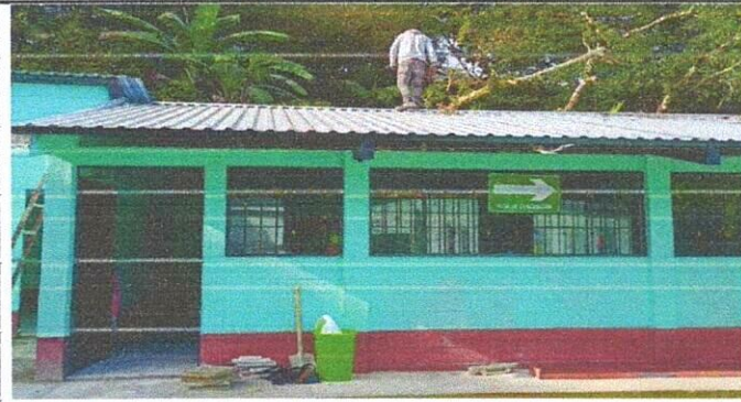
Foto 2: Instalación de canales
