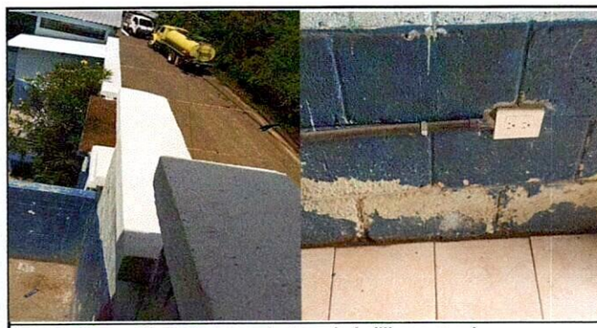
Foto 6:. Conexión de toma corrientes y boladillo en pared
