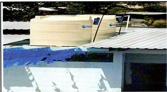
Foto 3:. Reinstalación de tinaco
