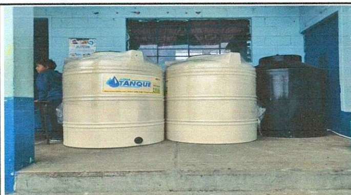
Foto 3:. Reinstalacion de tinaco
