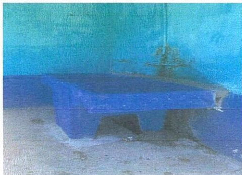
Foto1: Pila de cemento 1.
