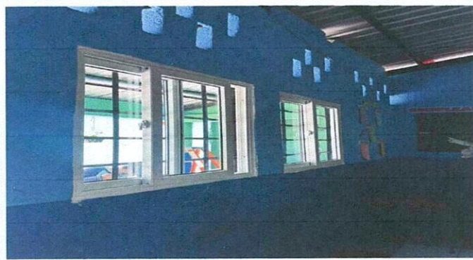
Foto 3: Ventanas PVC instaladas.
