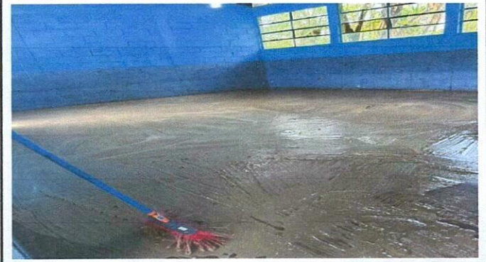
Foto 4: Aplicación de Adhesivo PSP previo a base ceentada con arena cernida.
