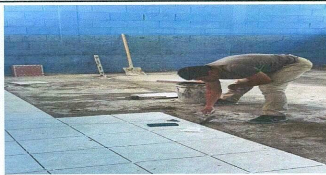
Foto 5: Colocación de piso Cerámico sobre base cementada con arena cernida.
