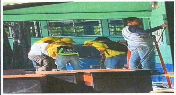
Foto 2: Instalación de ventanas PVC.
