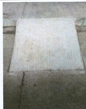
Foto 4: Rampas de acceso
