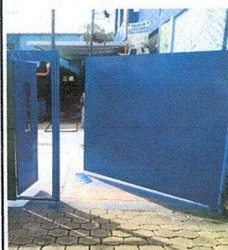
Foto 3: Reforzamiento y pintura del portón
