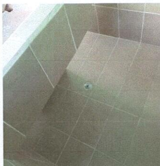
Foto 6: Reparación de pila
