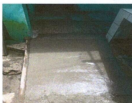
Foto 4: Rampas de acceso
