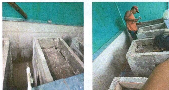
Foto 6: Reparación de pila
