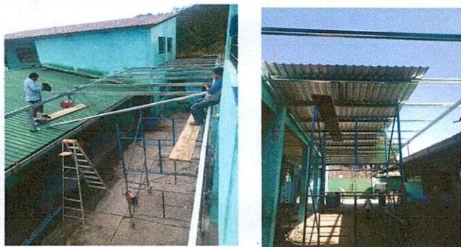
Foto1: Estructura metálica en el patio
