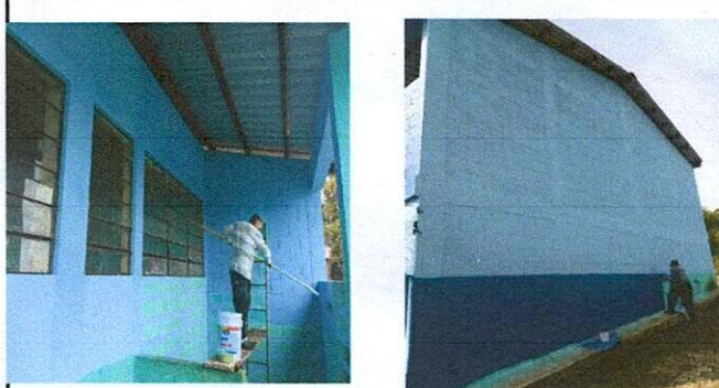
Foto 2: Pintura exterior e interior de la Escuela
