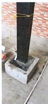
Foto 3: bases de concreto para columna techo de patio
