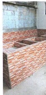
Foto 5: Colocacion de piso ceramico en pila
