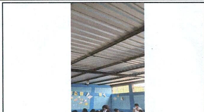
Foto1: Cambio de lamina techo de 3 aluas 2do. Nivel
