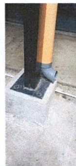
Foto 4: Insalaciones de estructura para techo de patio
