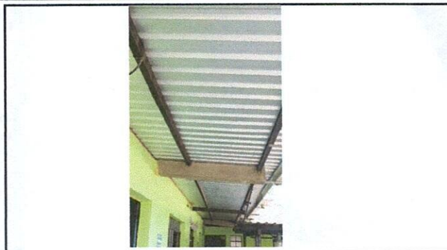
Foto 2: Cambio de lamina pasillo segundo nivel
