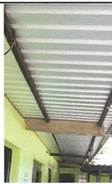
Foto 2: Cambio de lamina pasillo segundo nivel
