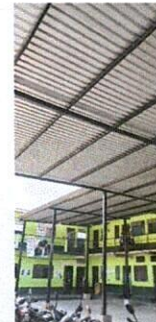
Foto 6: Instalacion de lamina en techo de patio
