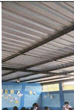
Foto1: Cambio de lamina techo de 3 aluas 2do. Nivel
