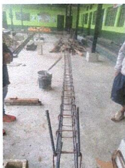
Foto1: Armado de bases techo patio
