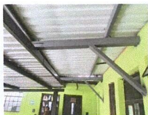
Foto 5: Cambio de canales y lamina techo 3 aulas 2do. Nivel
