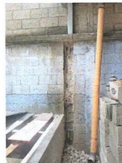
Foto 2: Armado de columnas techo patio
