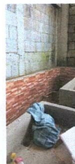
Foto 6: Instalacion de azulejos de pila.
