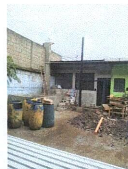
Foto 4: Insalaciones de costanera para techo de patio.
