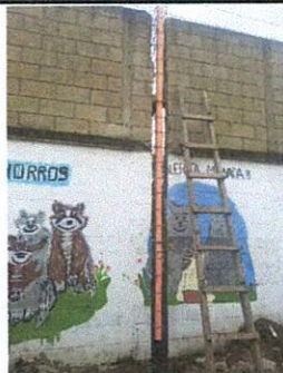
Foto 3: Columna y canal de desfogue de agua plubliales techo patio
