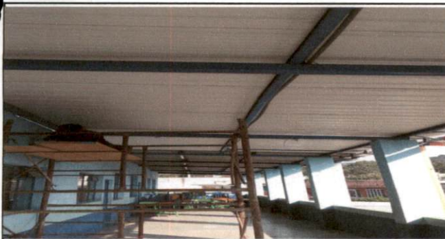
cambio de techo de corredor
