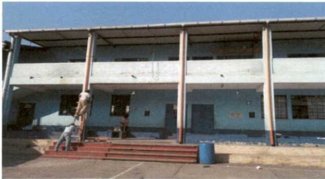
cambio de canales y bajadas de agua
