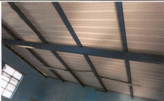
mantenimiento de canales
