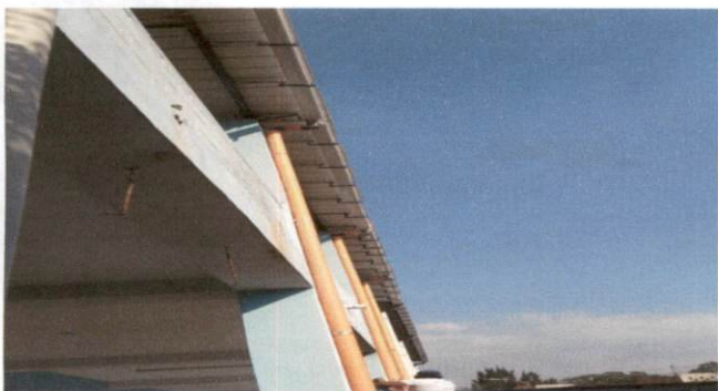
cambio de canales y bajadas plubiales
