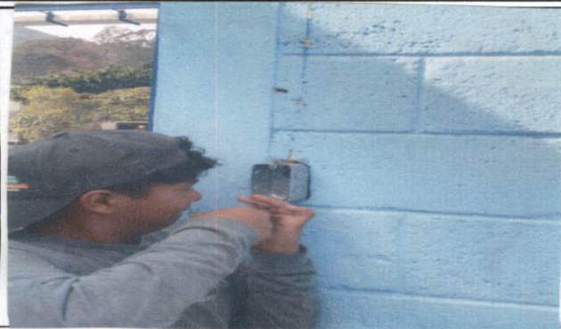
mejoramiento de electricidad
