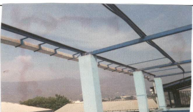
mantenimiento de costaneras
