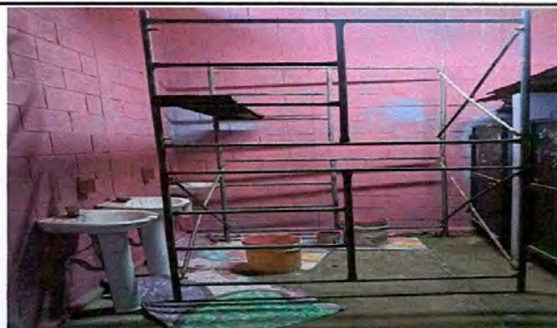
Foto: 1 pintura en baños
