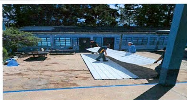
Foto: 2 colocacion de laminas
