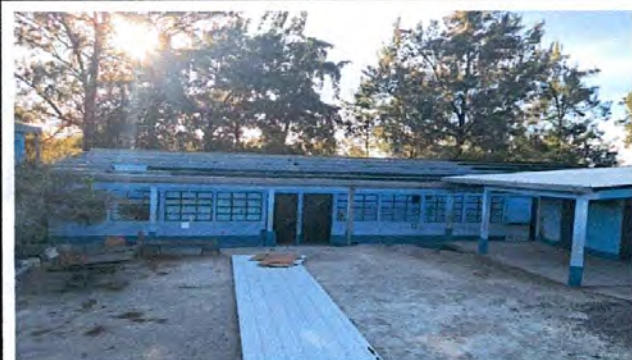
Foto: 3 mantenimiento de costaneras
