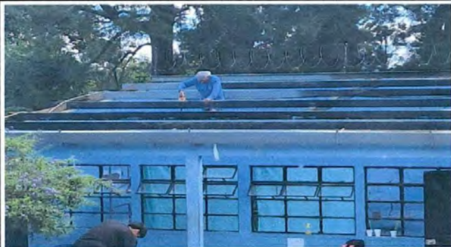
Foto: 1 Pintura y mantenimiento en costaneras
