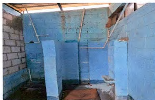
Foto: 4 cambio de cisterna de agua
