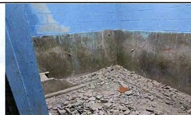
Foto: 3 Demolicion en baños de los niños para cambio a mingitorios
