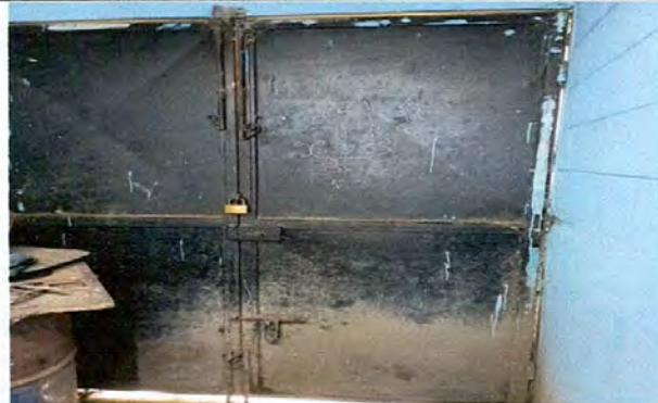
Foto: 2 restauración de portón trasero
