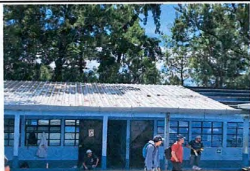
Foto: 5 cambio de lamina
