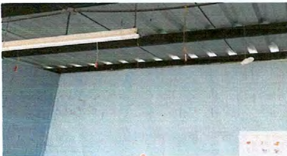
Foto: 6 cambio de lamina
