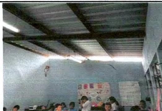
Foto: 4 cambio de lamina
