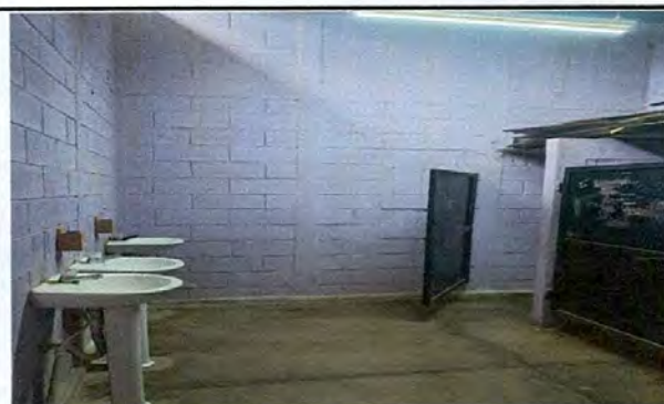
Foto: 4 pintura en baños
