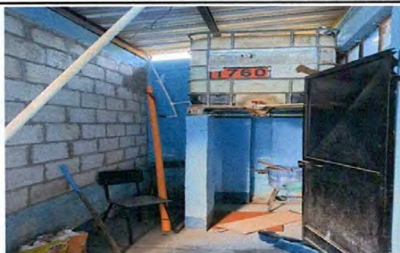
Foto: 3 cambio de cisterna de agua
