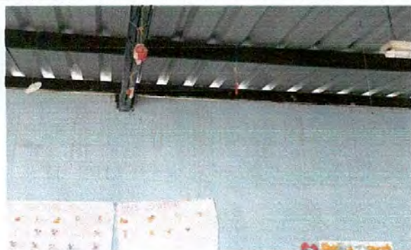
Foto: 3 pintura en costaneras
