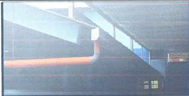
tuberia nueva para bajada de agua pluvial
