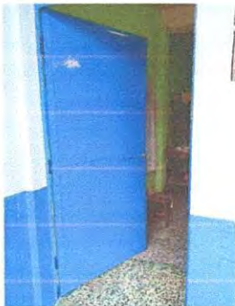
finalizacion de pintura y soldadura
