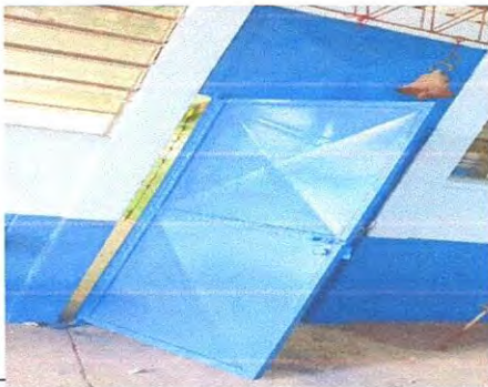
finalizacion de pintura
