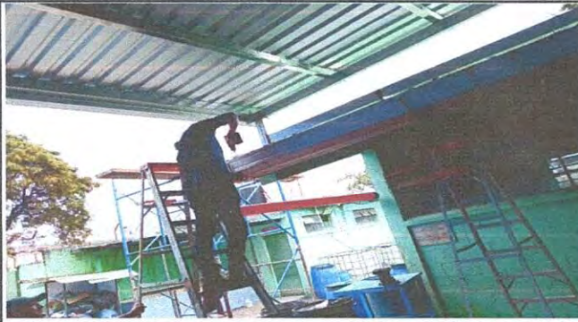
Cambio y reforzamiento de estructura
