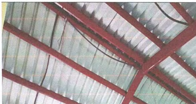
colocacion de ducto para proteccion de los cables electricos
