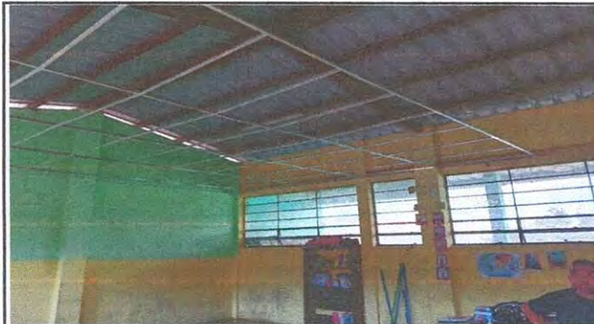
estructura de techo
