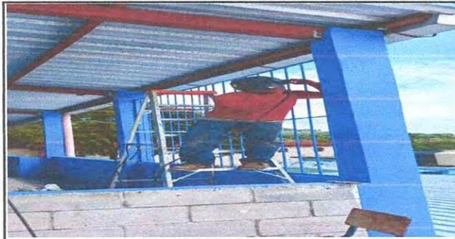
soldadura de la estructura para corredor
