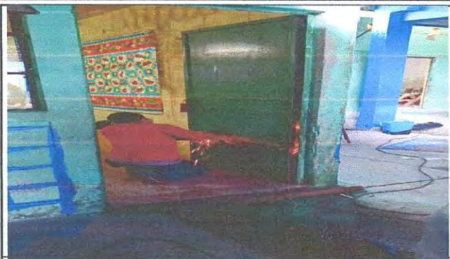
soldadura de cambio de lamina de puertas
