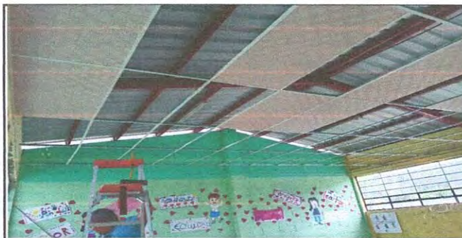
colocacion de duela de cielo falso
