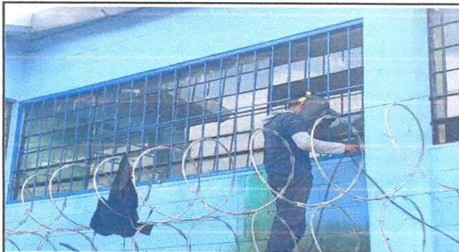
soldadura de la estructura de los balcones de la parte exterior de las ventanas
