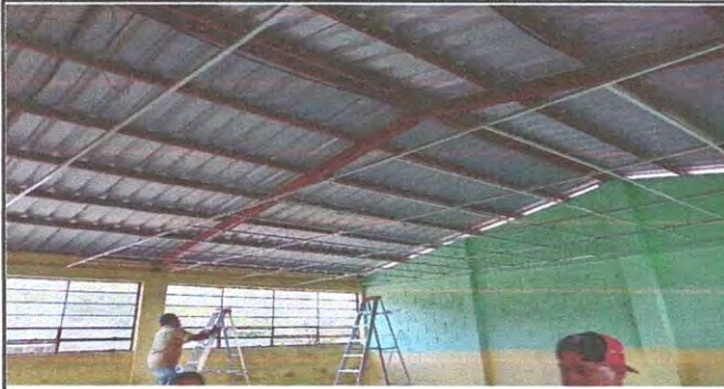
colocacion e la exructura para el cielo falso
