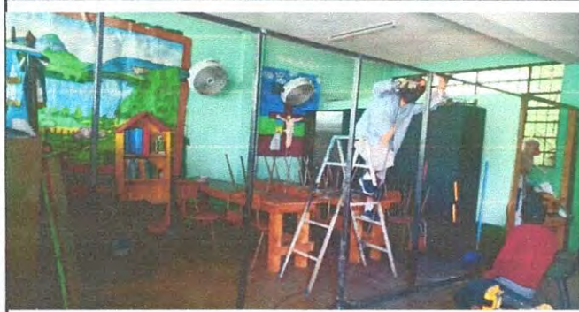
estructura metálica de la división de clase
