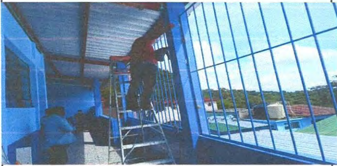
soldadura de la estructura para corredor
