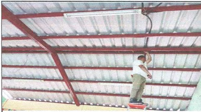
cambio de posicion y logitud de las instalaciones electricas
