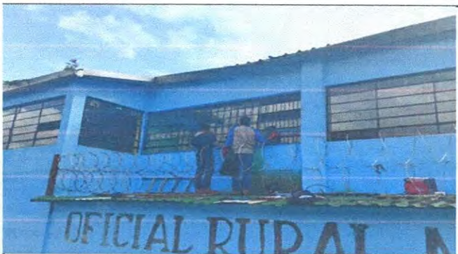
soldadura de las estructura metalica de los balcones
