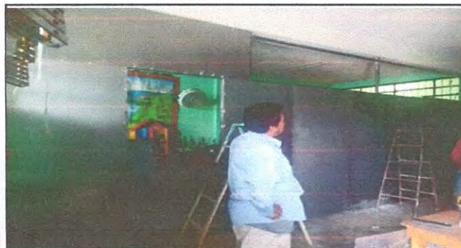
colocación de las láminas que forman la división de clase
