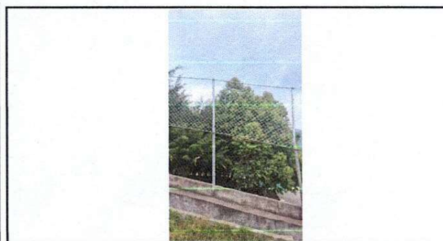
Foto 5: Remozamiento finalizado en cerca de malla perimetral de 125 metros lineales.
