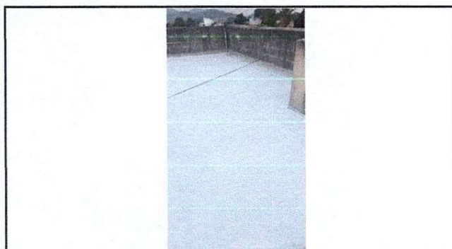
Foto 3: Area de 840 metros de terraza con impermeabilización terminada.
