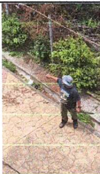
Foto 3: Limpieza del area de cerca para su instalación
