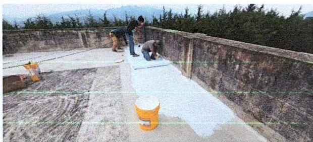
Foto 5: Inicio proceso de impermeabilización de los 840 metros de terraza
