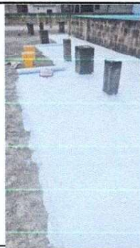
Foto 6: Proceso de impermeabilización de los 840 metros de terraza
