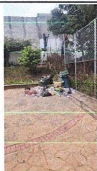
Foto 4: Inicio proceso de remozamiento de cerca de malla perimetral de 125 metros lineales.
