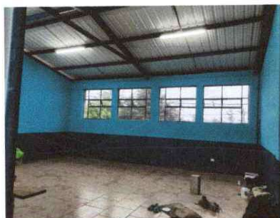
Foto 4: instalación de ventanas (vista lateral)
