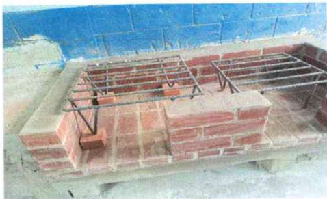
Foto1: cocina en construcción
