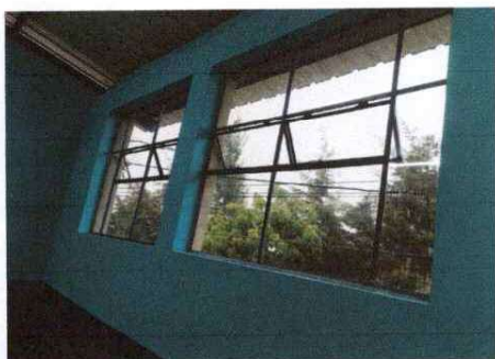
Foto 3: instalación de ventanas
