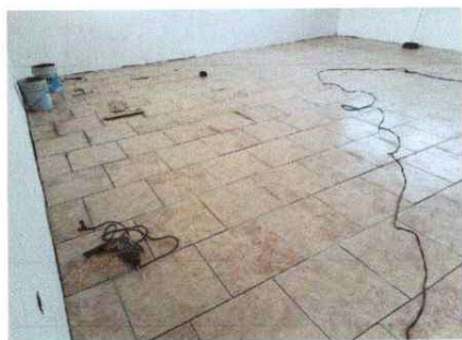
Foto 5: instalación de piso nuevo
