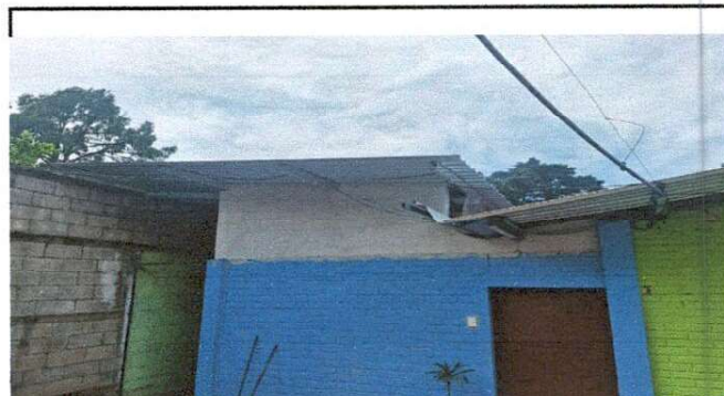
Foto 4 Levantado de Techo en cocina
