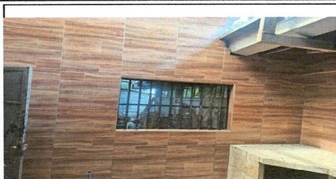
Foto 1 Cocina sustitucion de Azulejo
