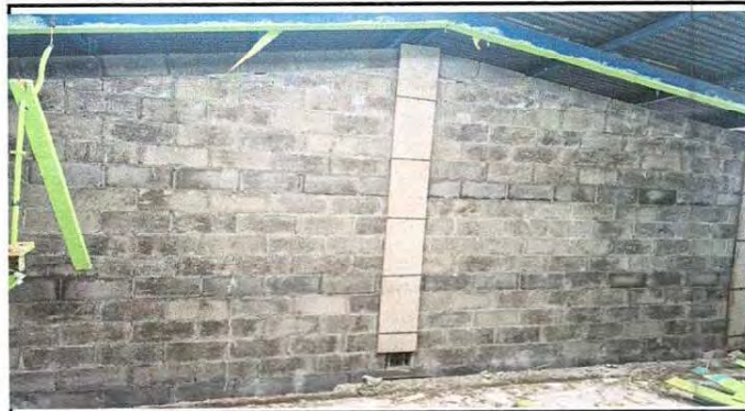
Levantado de pared zanjeo y cimient
