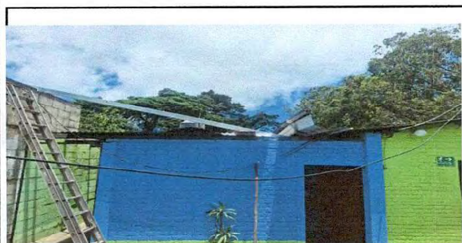
Levantado de Techo en cocina
