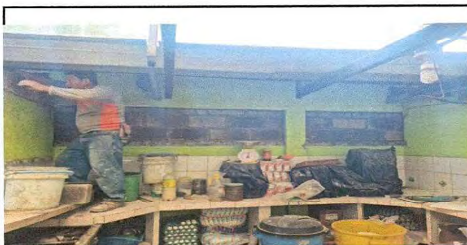
sustitución de azulejo en cocina
