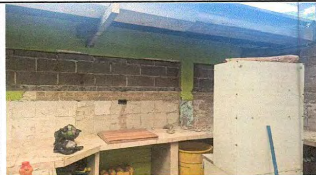
Foto 2 Sustitucion de Azulejo en cocina
