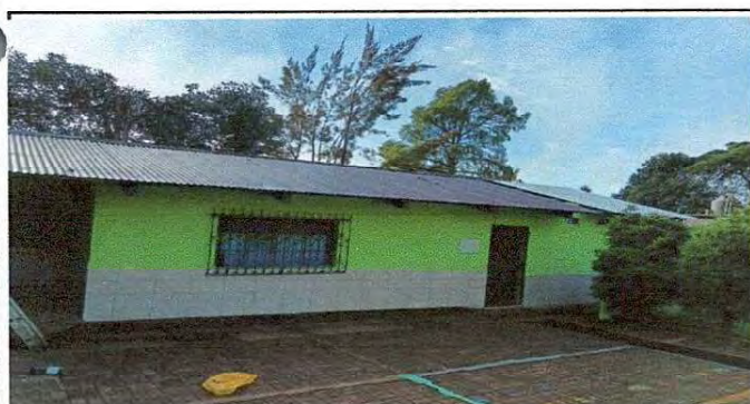
Foto 5 sustitución de Lamina en Laboratorio de Computación.
