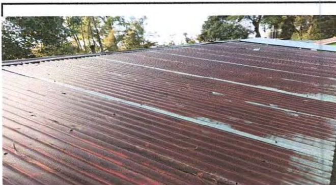
Suatiución de Lamina en laborator de computación
