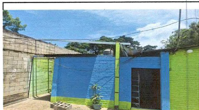
Foto 4 Levantado de Techo en cocina
