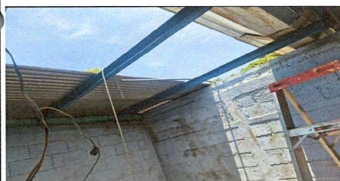
Levantado de Techo en cocina
