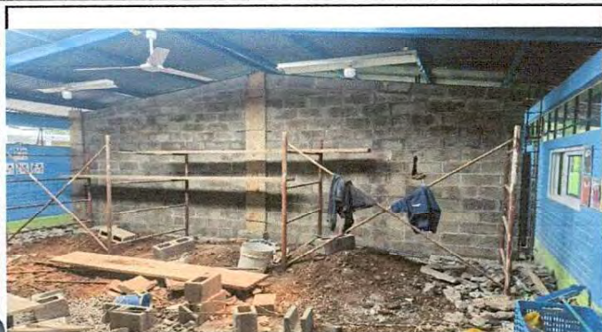
Levantado de Pared, Zanjeo y cimient
