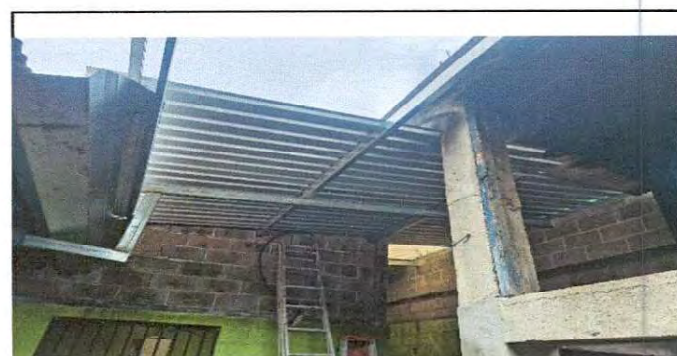
Foto 4 Levantado de Techo en cocina
