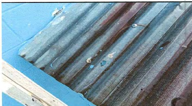
Foto 6 sustitucion de lamina en laboratorio de Computación
