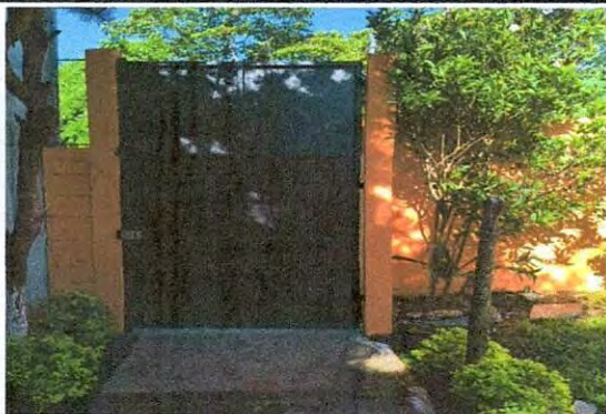
Foto1: Mantenimiento de portón principal.
