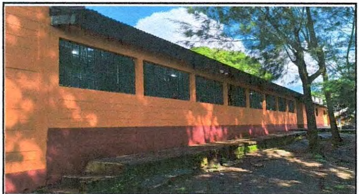
Foto 4: Pintura de atrás concluida módulo 3.
