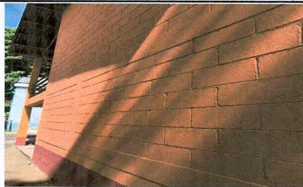
Foto 5: Pintura concluida de lateral módulo 3.
