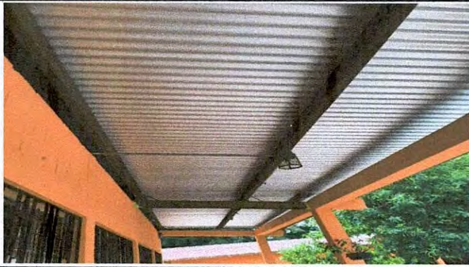
Foto1: Colocación de lámina en módulo 1 concluida.
