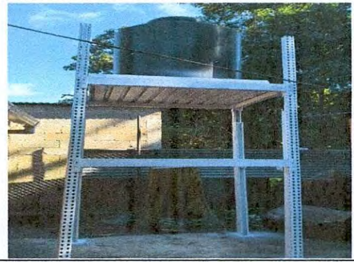
Foto 2: Estructura y rotoplas remozado.
