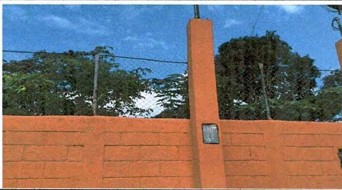
Foto 3: Malla y muro perimetral.
