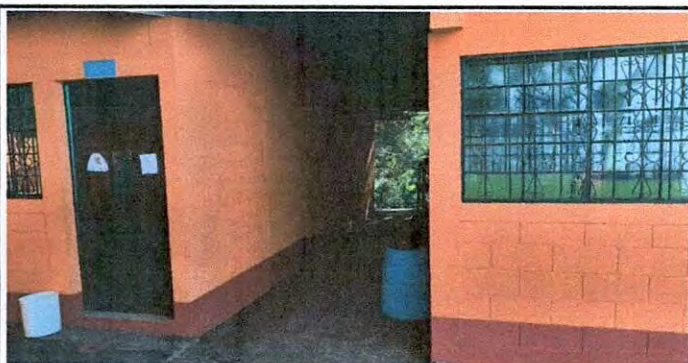
Foto 5: Pintura exterior de la escuela módulo 2.
