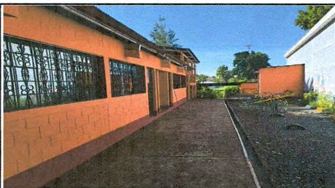
Foto 4: Pintura exterior de la escuela módulo 2.
