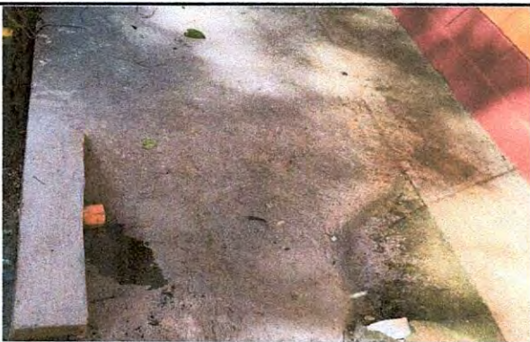
Foto 3: Fundición y colocación de desagüe de módulo 2.
