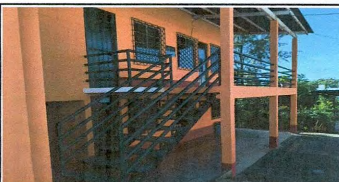
Foto 6: Pintura exterior de la escuela módulo 3.
