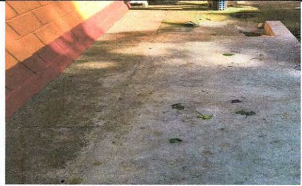
Foto 2: Fundición de banqueta módulo 2
