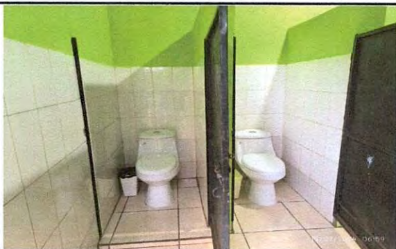
Foto 3: Colocación de sanitarios en baño de niños.
