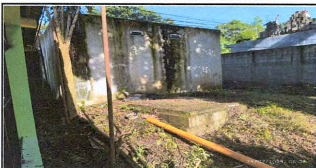
Foto 6: Remoción malla perimetral, módulo 1.
