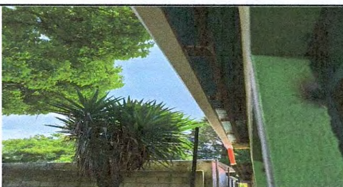
Foto 6: Colocación de canal de parte de atrás de módulo 1.
