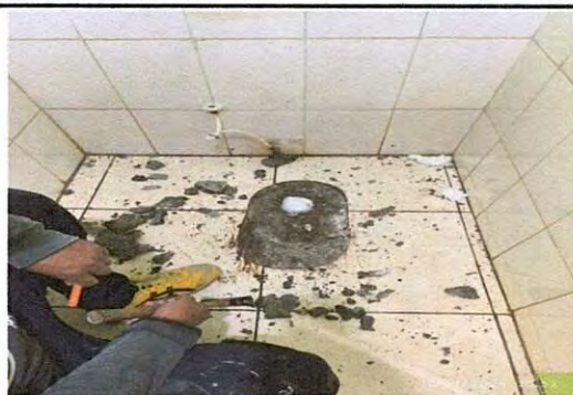
Foto 2: Cambio de sanitarios, baño de niños.
