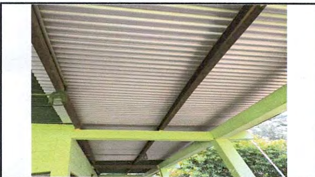
Foto 3: Cambio de lámina módulo 1.
