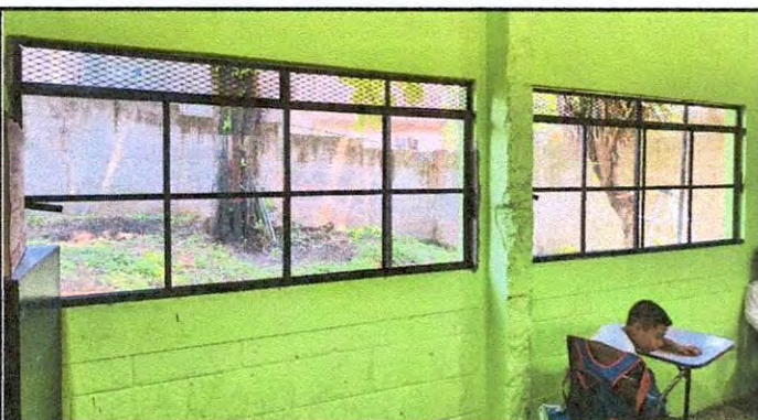
Foto 3: Ventana de primer grado módulo 1.
