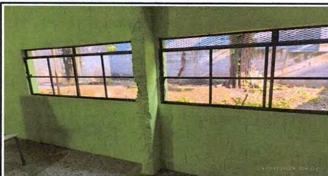
Foto 5: Colación de ventanales primer grado.
