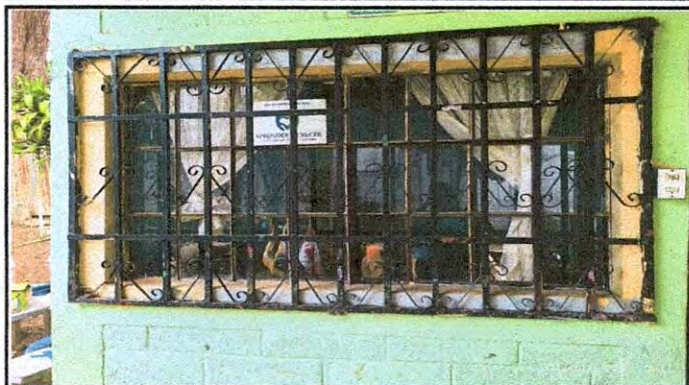
Foto 2: Balcón a sustituir
