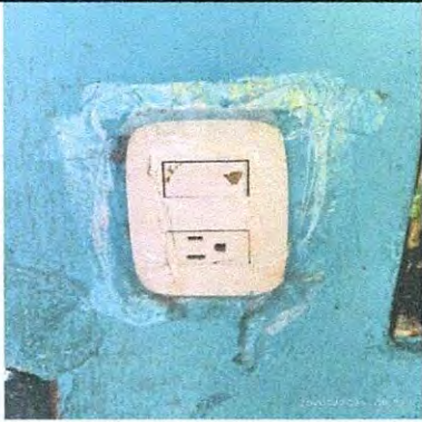
Foto 1: Cambio de interruptores de luz, 4 en total.
