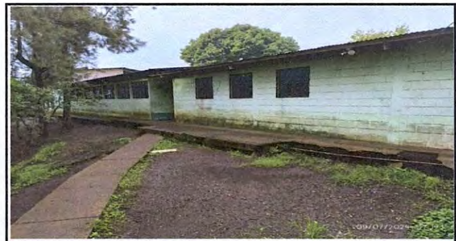
Foto 6: Instalaciones previo a pintar.
