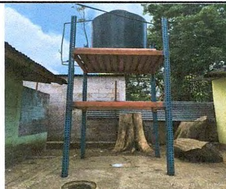
Foto 4: Tinaco e infraestructura para mantenimiento
