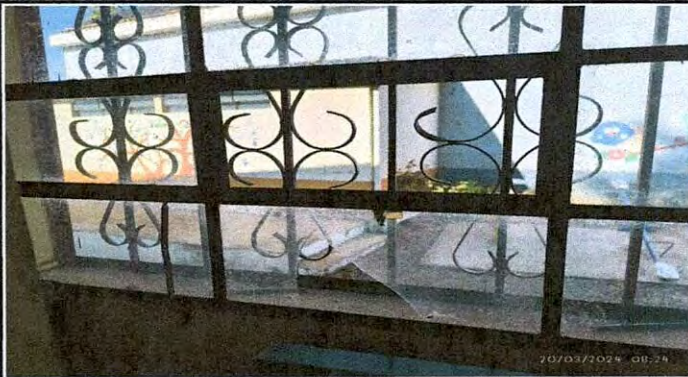
Foto 3: Cambio de viarios rotos, 9 en total.
