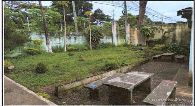
Foto 2: Instalaciones previo a pintar.
