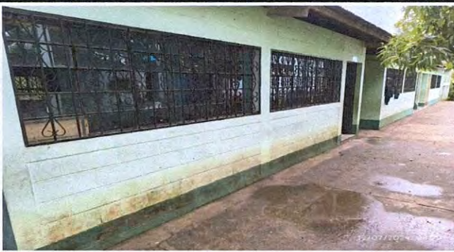
Foto 3: Instalaciones previo a pintar.
