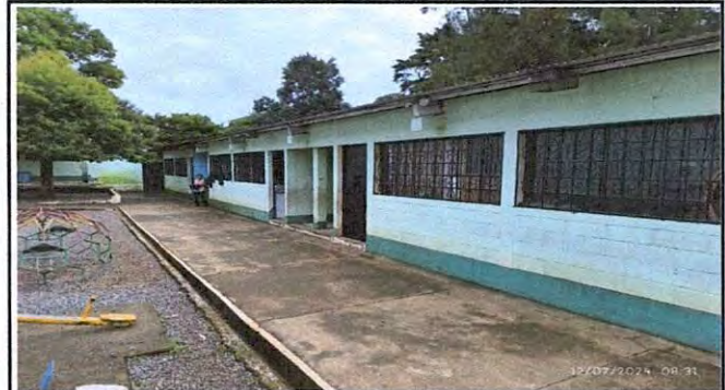
Foto 4: Instalaciones previo a pintar.
