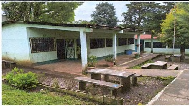
Foto 1: Instalaciones previo a pintar
