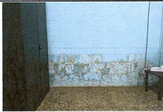
Foto 6: Aplicación de impermeabilizante en paredes externas por filtración de agua.
