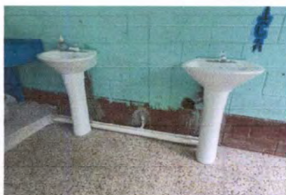
FOTO 7: INSTALACIÓN DE LAVAMANOS CON SUS ACCESORIOS
