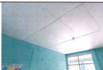
FOTO 11: SUSTITUCIÓN DE CIELO FALSO RETICULADO DE 2' X 4'
