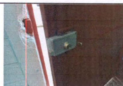
FOTO 12: SUSTITUCIÓN DE CHAPAS EN PUERTAS
