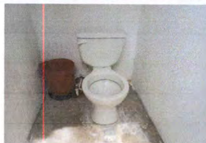
FOTO 8: INSTALACIÓN DE INODOROS EN BAÑOS, FALTA INSTALAR LAS TAPADERAS Y ASIENTOS DE LOS DOS INODOROS.
