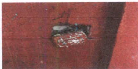
Foto 13: Reparación cableado eléctrico
