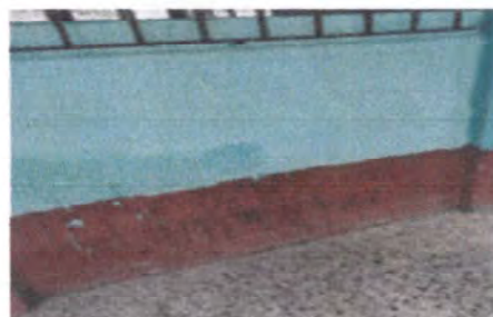
Foto 16: Pintura en paredes del segundo nivel (externo)
