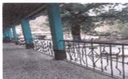
Foto 10: Mantenimiento de barandas
