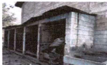
Foto: 2 Área del baño, cambio de láminas 10
