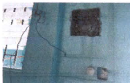
Foto 12: Reparación cableado eléctrico
