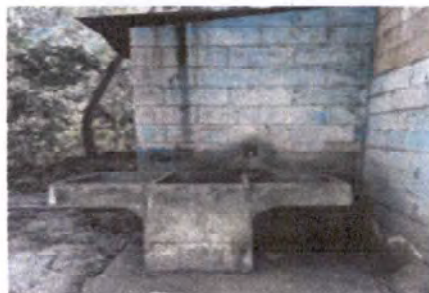
Foto 8: Mantenimiento en puertas de servicio sanitario
