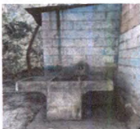
Foto 15: Sustitución e instalación de pila, drenaje y colocación tubo
