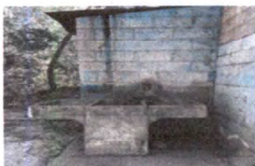
Foto 11: Reparación área baños, plancha de concreto
