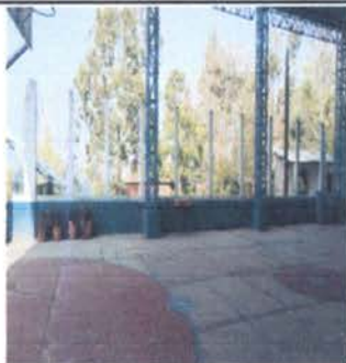
Foto7: SUSTITUCION DE MALLA EN MAL ESTADO PATIO PRINCIPAL
