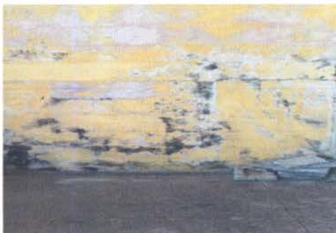
Foto 13: REPARACION DE MUROS DE HUMEDAD Y APLICACIÓN DE PINTURA
