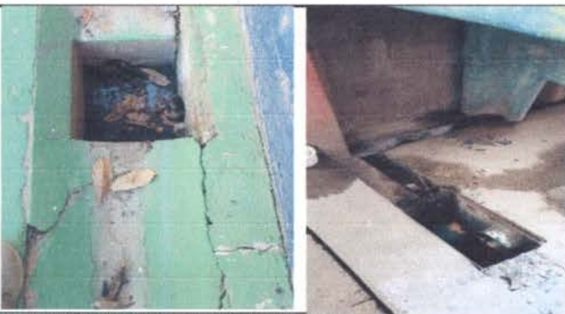
Foto 5: REPARACION RED DE DRENAJE / CAJAS
