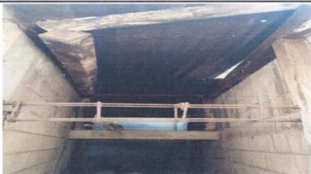
Foto 1: SUSTITUCION DE TECHO EN BODEGA Y COLOCACION DE PUERTA DE REJAS
