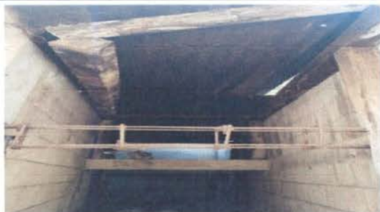
Foto9: instalacion de luz en la bodega
