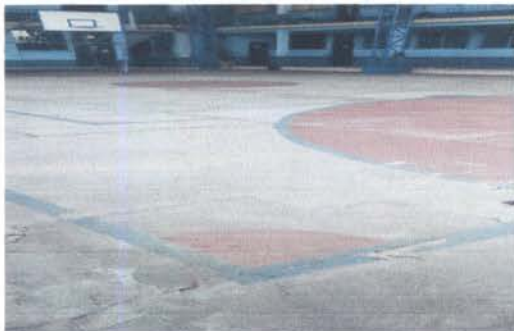
foto 15: aplicación de pintura en toda la escuela
