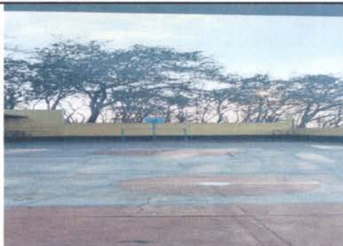
Foto 4: reparacion de piso liso en cancha y callegon
