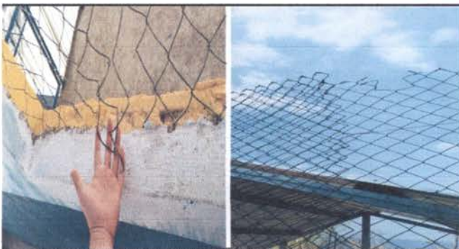
Foto 6: SUSTITUCION DE MALLA EN MAL ESTADO PATIO PRINCIPAL
