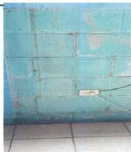
foto 11: repello en pared de direccion y en paredes de salones, callejon, bodega.
