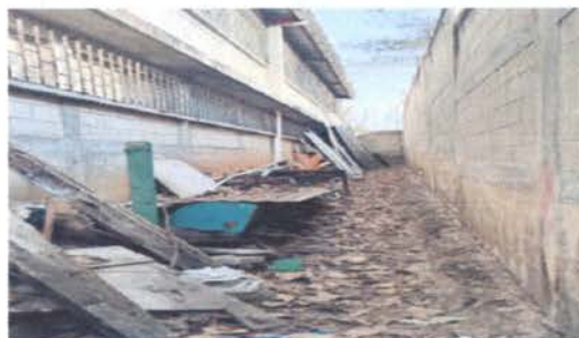
Fto 10: prepello en paredes y aplicación de torta de cemento en callejon
