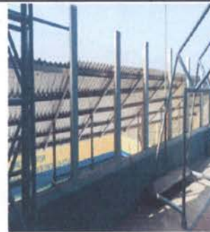
Foto 8: SUSTITUCION DE MALLA ESTADO PATIO PRINCIPAL
