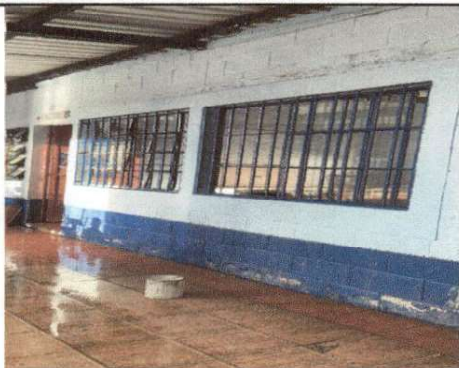
Foto No. 1: Se instala ventana y Balcon en el salón que se contemplo para cocina
