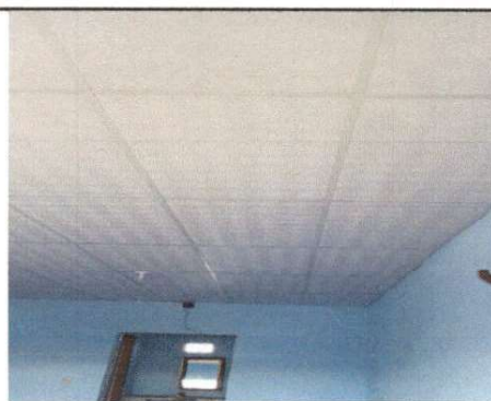
Foto. No. 4: Salon No. 44 donde se cambio techo.
