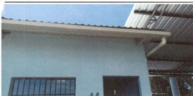
Foto No. 5: Parte de frente de Salón donde se cambio techo.
