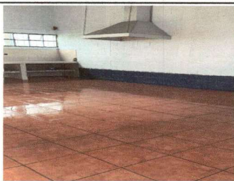
Foto No. 2: Chimenea que se coloco en la cocina.
