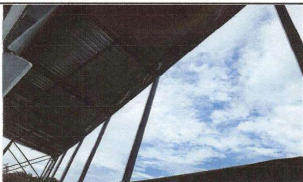
Foto No. 5: el Trabajo de instalación de techo en pasillo que conecta los dos módulos.
