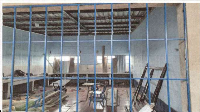
Foto No. 1: Se Realiza una nueva ventana siendo trabajo extra ya que no estaba contemplado en el proyecto.
