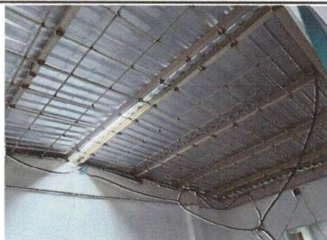
Foto No. 4: Se coloco nuevo techo y antes de colocarle cielo falso a salón No. 44 se coloca rejas en techo por seguridad.
