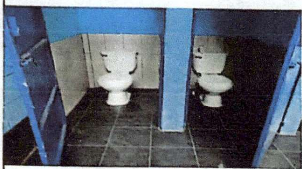
FOTO 3. SE INSTALARON NUEVOS SANITARIOS Y AZUJELOS
