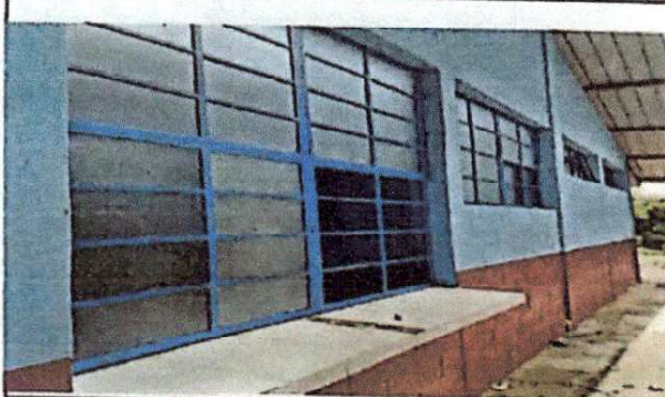
FOTO 4. SE REALIZO UNA VENTANA PARA DESPACHADOR DE REFACCION PARA LOS NIÑOS EN LA COCINA.
