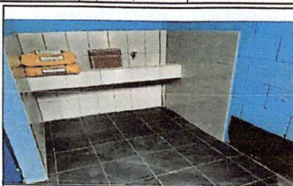
FOTO 2. SE CONSTRUYO UN LAVAMANO DE CONCRETO Y SE LE COLOCO AZUJELOS
