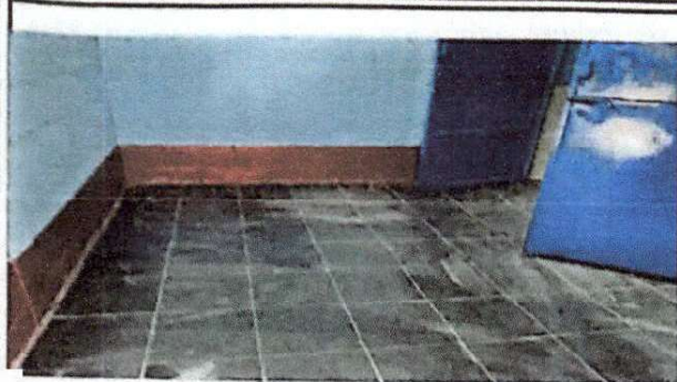
FOTO 1. SE COLOCO CERAMICA EN LOS BAÑOS, SE PINTARON PUERTAS Y PAREDES
