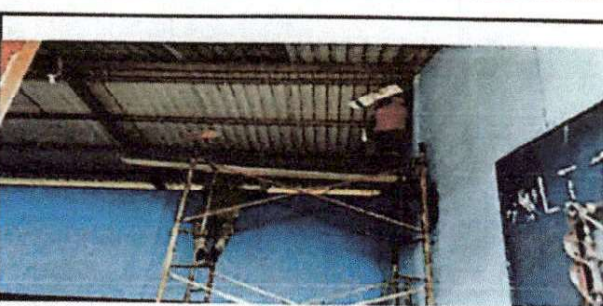
FOTO 6. SE REALIZO EL CAMBIO DEL SISTEMA ELECTRICO, CABLE, BOMBILLAS, APAGADORES Y TOMA CORRIENTES.
