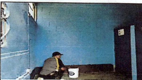
FOTO 4. SE PINTARON LAS PAREDES DE LOS BAÑOS Y LAS PUERTAS
