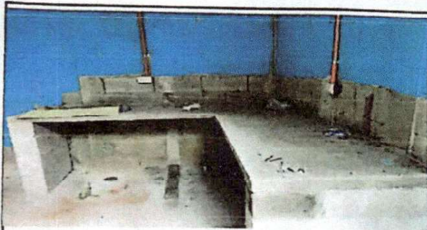
FOTO 3. SE CONSTRUYO UNA MESA DE CONCRETO EN LA COCINA
