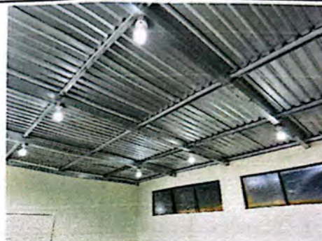
Foto 8: Se puede apreciar la colocación de la estructura metálica de techo + lámina troquelada + iluminación led.
