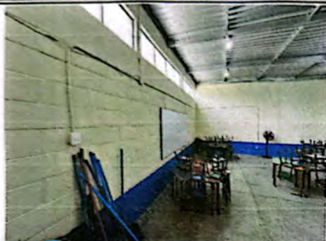
Foto 7: Se puede apreciar la colocación de la estructura metálica de techo + lámina troquelada + iluminación led.
