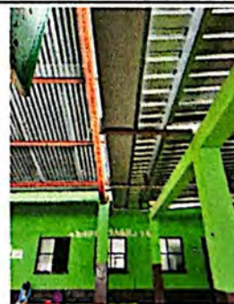
Foto 6: Suministro e instalación de lámina troquelada en salones de clases.
