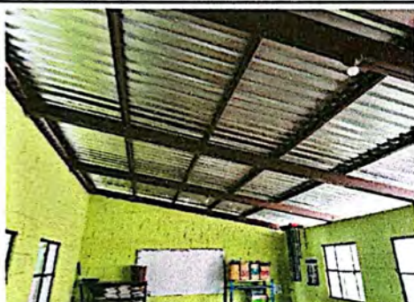
Foto 3: Se retiran las láminas en mal estado para realizar el mantenimiento a la estructura de soporte.
