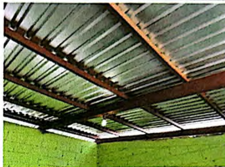
Foto 2: Desmontaje de láminas en malas condiciones.
