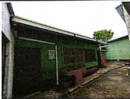
Foto 10: Suministro e instalación de canal + tubería de descarga pluvial.
