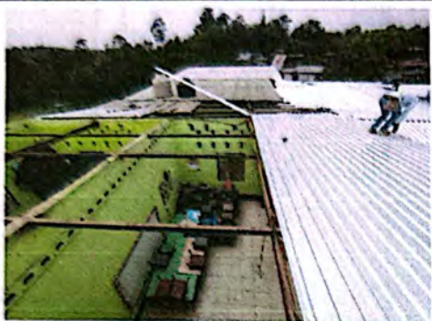
Foto 7: Suministro e instalación de lámina troquelada en Salones.
