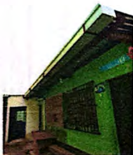
Foto 9: Suministro e instalación de canal pluvial.
