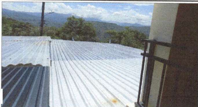
Foto1: TECHADO DE LAMINA EXTERIOR
