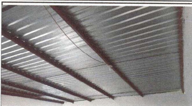
Foto 2: TECHADO DE LAMINA INTERIOR
