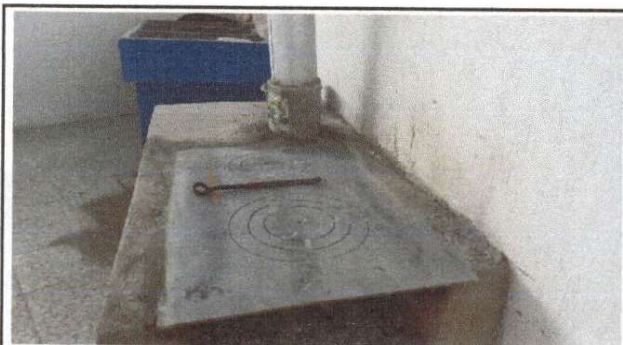
Foto 3: CAMBIO DE PLANCHAS DE COCINA
