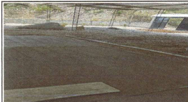
Foto 3: FUNDICION DE PLANCHAS DE CONCRETO
