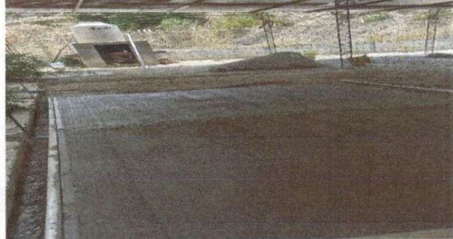
Foto 4: FUNDICION DE PLANCHAS DE CONCRETO
