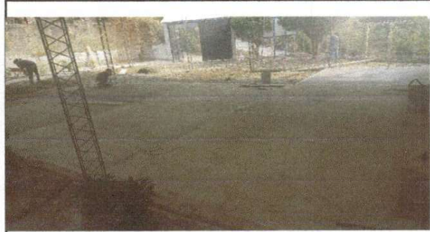
Foto 2: FUNDICION DE PLANCHAS DE CONCRETO
