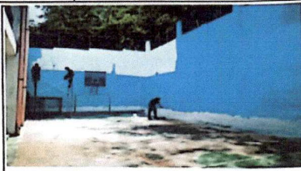
Foto 2: AVANCES DE LA PINTADA DEL MURO
