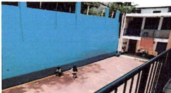
Foto 4: AVANCES DE PINTADO DEL MURO
