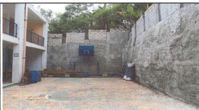
Foto 3: Repello del muro
