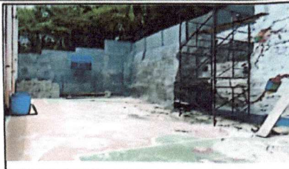
Foto 2: Repello de muro
