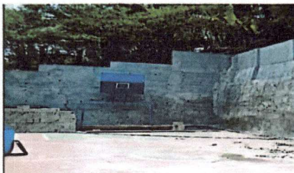
Foto 3: AVANCES DEL MURO
