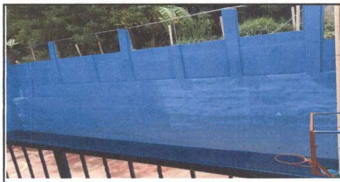
Foto 6: Finalización del muro perimetral
