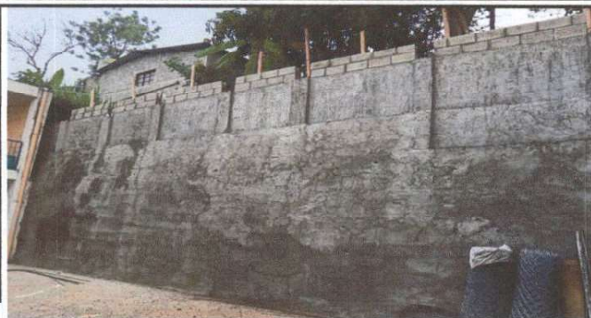
Foto 1: inicio del muro perimetral
