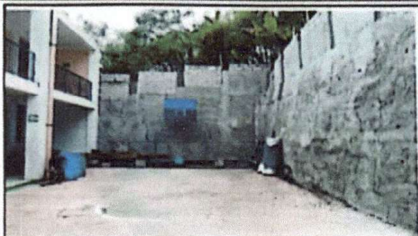
Foto 1: SEGUIIMIENTO DEL REPELLO
