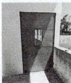
Foto 5: Puerta de entrada a la construcción
