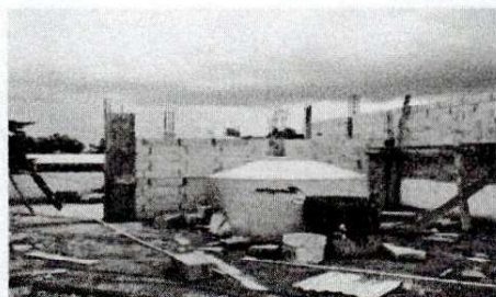
Foto 5: Disión de la segunda parte de la construcción
