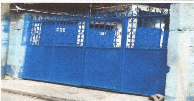
Foto 5: Mantenimiento de portón.
