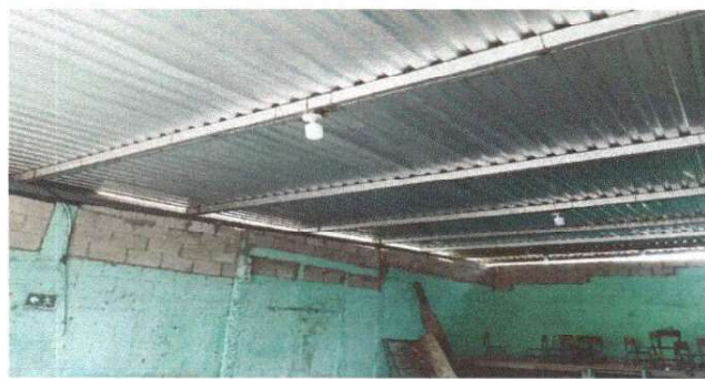
Foto 3: Levantado de muro.
