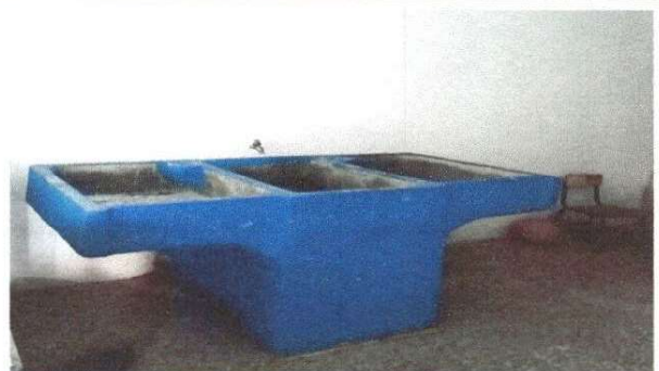
Foto 4: Colocación de pila.
