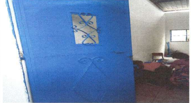
Foto 2: Mantenimiento de puertas, completo.
