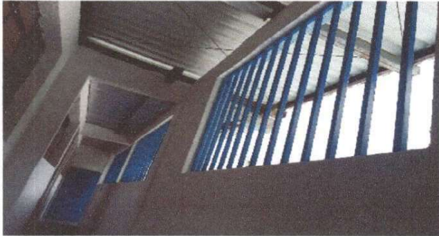
Foto 1: Instalación de balcones, completo.
