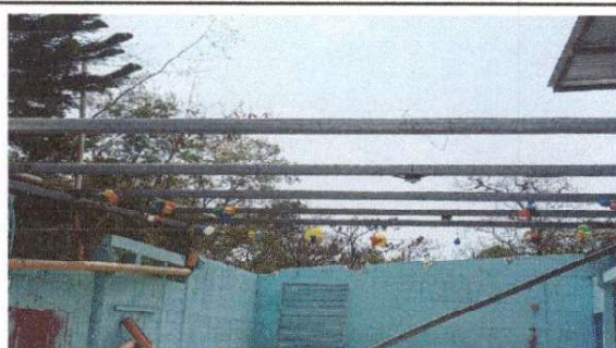
Foto 2: Desmontaje de lámina.
