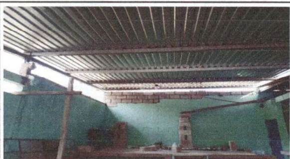
Foto 3: Levantado de muro.
