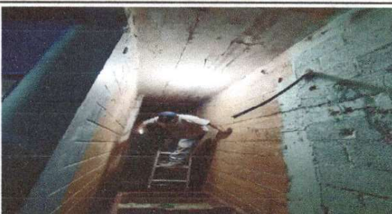
Foto 6: Instalación de sistema eléctrico.
