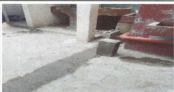
Foto 5: Instalación tubería agua potable.
