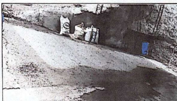
Foto 4: LOSA DE CONCRETO EN EL PATIO
