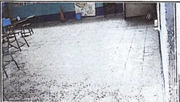
Foto 1: FINALIZACION DE COLOCACION DE PISO
