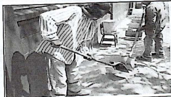
Foto 4: LOSA PARA EL PATIO
