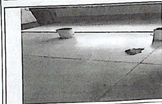
Foto 5: NIVELACIÓN Y COLOCACIÓN DE PISO
