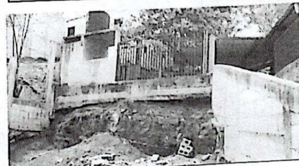
Foto6: COLOCACIÓN DE BARANDAL
