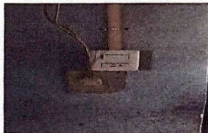
Foto 4: finalización de accesorios eléctricos toma corrientes.
